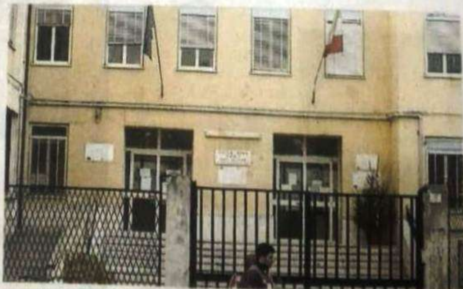
LA MEDIA ALIGHIERI L'intervento riguarda l'adeguamento sismico
